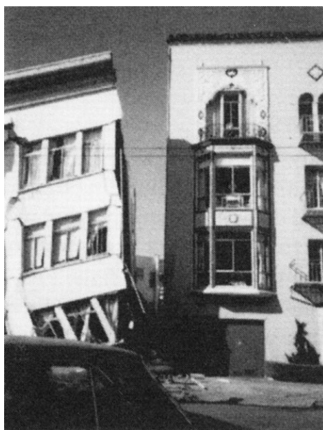
شکل ۱-۲ برخورد بین دو ساختمان در زلزله لوما پریتا ۱۹۸۹
